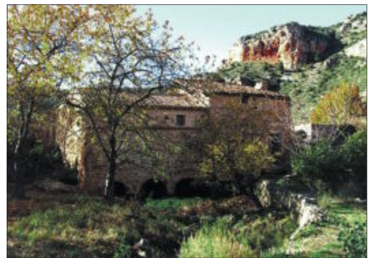
El molino conserva la fachada exterior de piedra.
